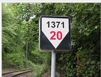
Úsek železniční trati o délce 1371 metrů s klesáním 20 ‰. Během metrového úseku (1000 mm) klesne trať o 20 milimetrů.
